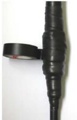
由一端开始，半重叠绕包防水胶带，将胶泥区域完全覆盖，共绕3层。
