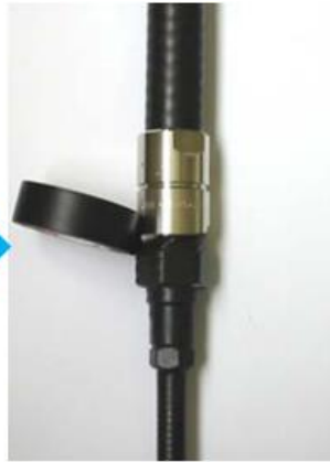
由一端开始，半重叠绕包一层绝缘防水胶带。
