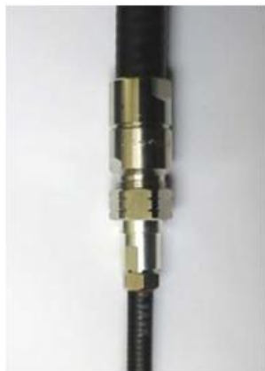
施工前，先清洁线缆、接头及所需包裹区域。
