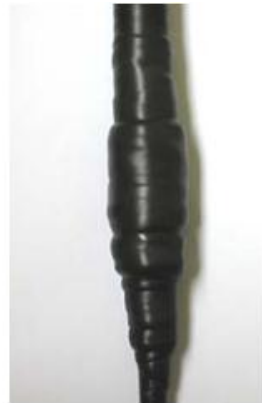
收尾时要用剪刀剪断并压紧，避免因翘边而且影响防潮效果。
