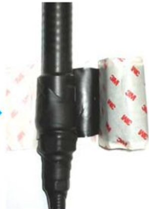
半重叠绕包防水泥，绕时均匀拉伸胶泥（拉伸至原宽度的3/4），共绕3层，每层都要拉紧压实，避免松脱。
